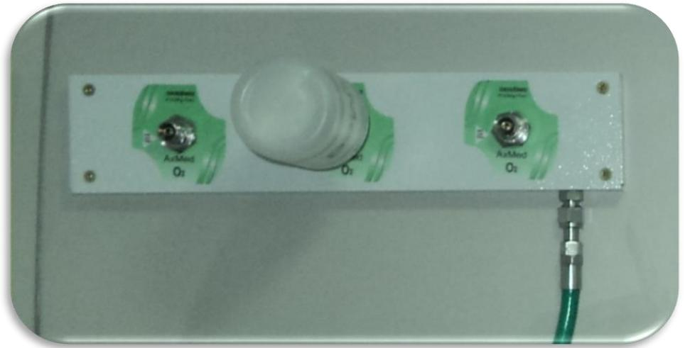
Réguas tripla completa com fluxometro, frasco aspirador, umidificador, chicote e máscara.
