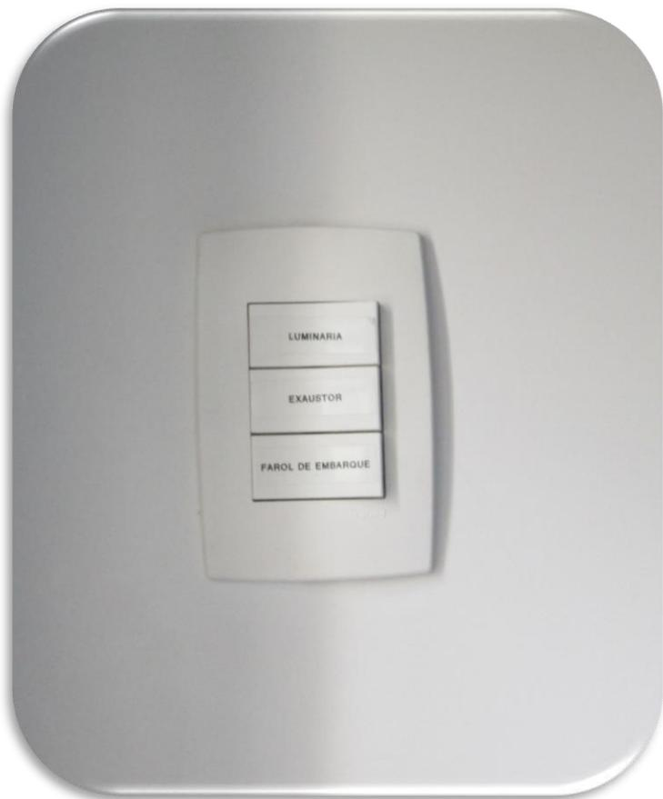
Interruptor triplo para acionamento dos equipamentos
